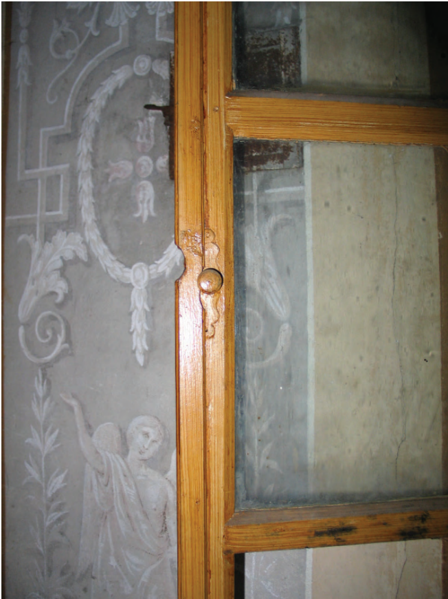
Ohranjena okenska krila in okna v kapeli dvorca nam dajo dovolj podatkov za verodostojno rekonstrukcijo vseh oken na dvorcu, prav tako pa podlago za pripravo načrtov za okni in vrata v slavnostni dvorani.
