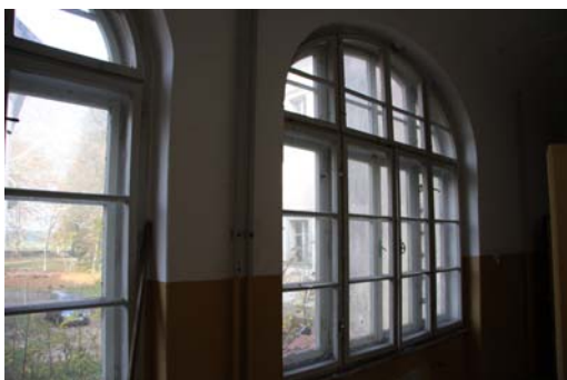
Okna z prvo vgradnjo in se restavrirajo.
