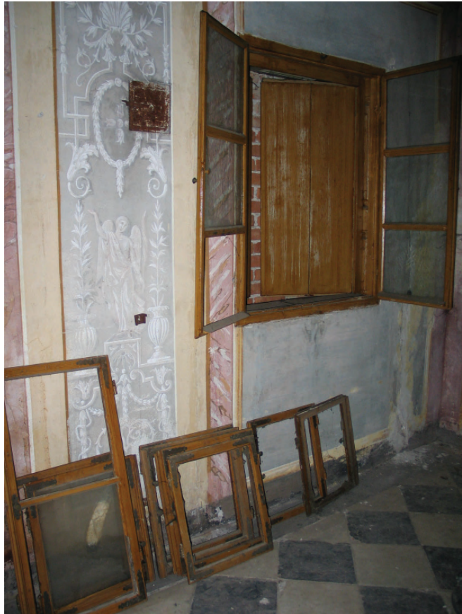
Ohranjena okenska krila in okna v kapeli dvorca nam dajo dovolj podatkov za verodostojno rekonstrukcijo vseh oken na dvorcu, prav tako pa podlago za pripravo načrtov za okni in vrata v slavnostni dvorani.
