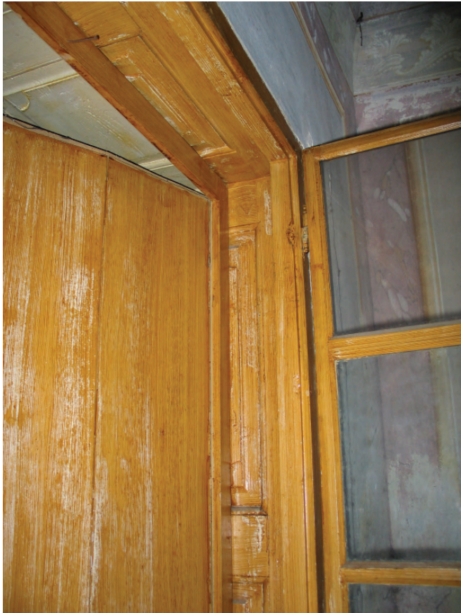
Ohranjena okenska krila in okna v kapeli dvorca nam dajo dovolj podatkov za verodostojno rekonstrukcijo vseh oken na dvorcu, prav tako pa podlago za pripravo načrtov za okni in vrata v slavnostni dvorani.
