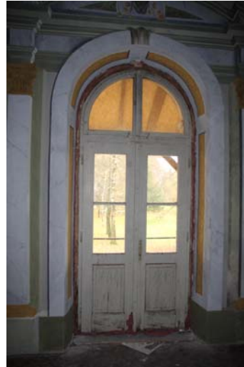
Obstoječa notranja vratna krila škatlastih vrat po sanaciji špalet
