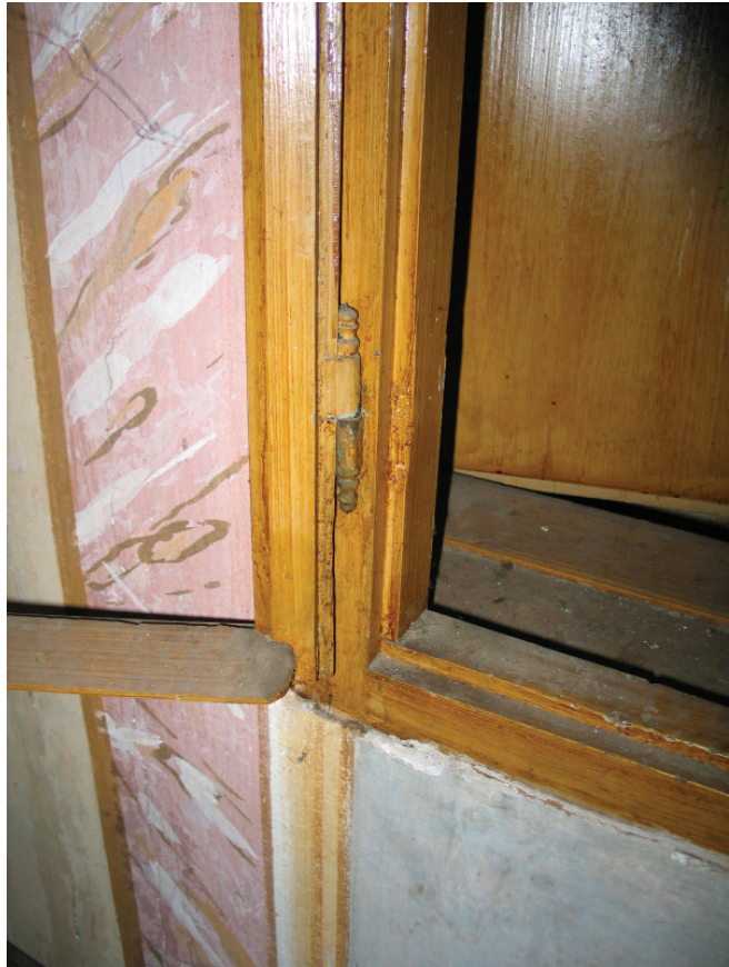
Ohranjena okenska krila in okna v kapeli dvorca nam dajo dovolj podatkov za verodostojno rekonstrukcijo vseh oken na dvorcu, prav tako pa podlago za pripravo načrtov za okni in vrata v slavnostni dvorani.
