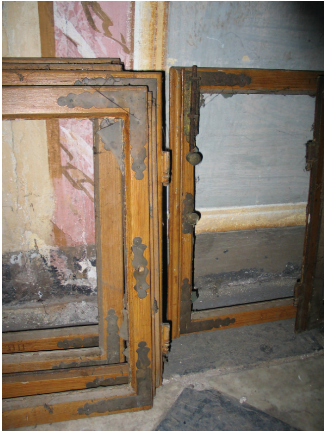
Ohranjena okenska krila in okna v kapeli dvorca nam dajo dovolj podatkov za verodostojno rekonstrukcijo vseh oken na dvorcu, prav tako pa podlago za pripravo načrtov za okni in vrata v slavnostni dvorani.
