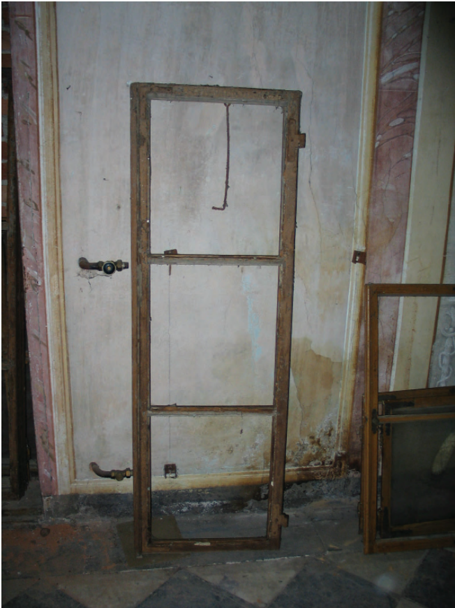
Ohranjena okenska krila in okna v kapeli dvorca nam dajo dovolj podatkov za verodostojno rekonstrukcijo vseh oken na dvorcu, prav tako pa podlago za pripravo načrtov za okni in vrata v slavnostni dvorani.
